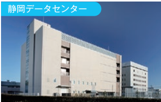
静岡データセンター
