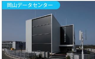
岡山データセンター
