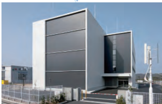
岡山データセンター
