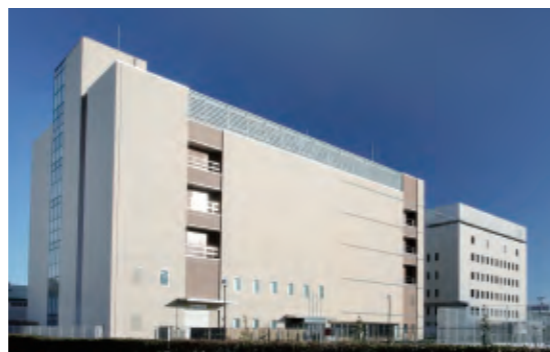
静岡データセンター
